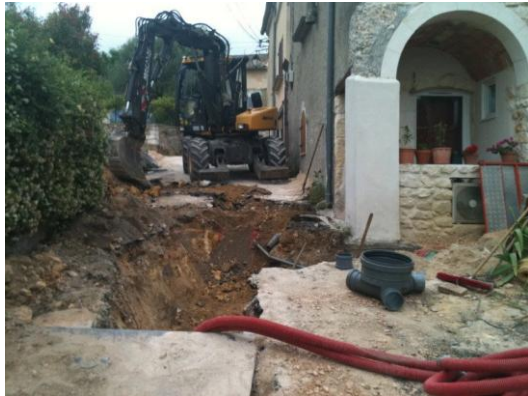
Pendant les travaux
