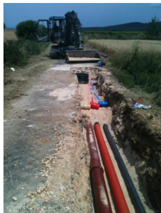
Vue de la tranchée
