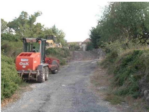
Pendant les travaux
