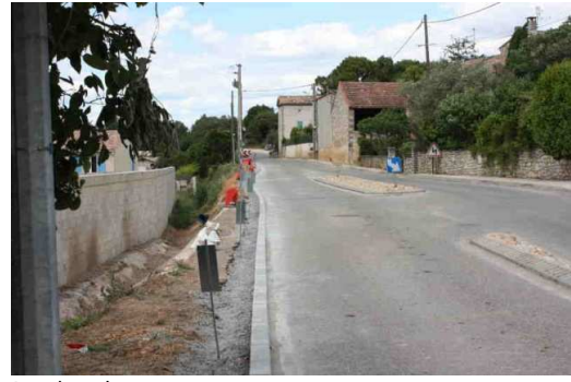
Pendant les travaux
