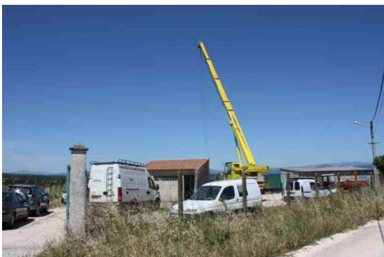
Pendant les travaux
