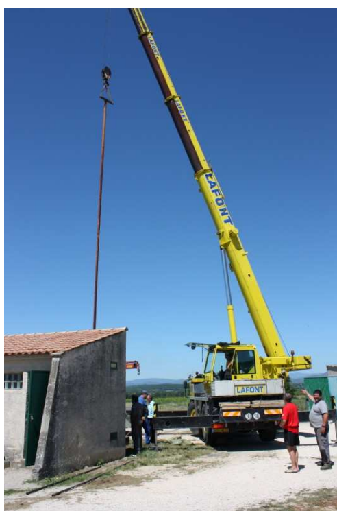
La station de pompage et la grue lors du changement de pompe en juin dernier
