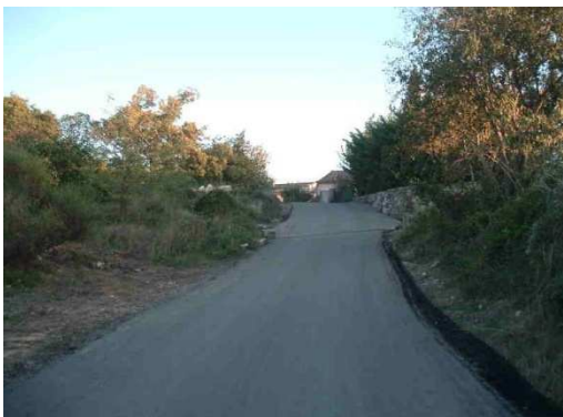
Après les travaux
