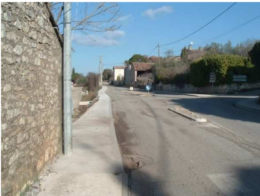
Après les travaux
